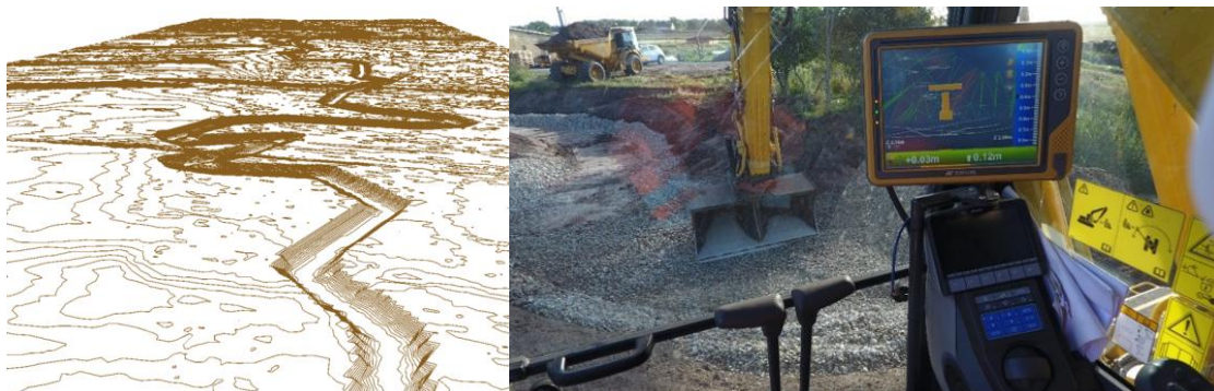
Figur 3: Gravefiler som konturlinjer vist i hhv. GIS og som efterfølgende er lagt ind i gravemaskinen.
