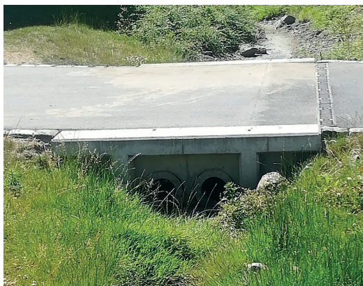
Figur 1. Bro over mindre vandløb i Vennelystparken i Aarhus, hvor en hydrologisk tilpasning vil være nødvendig for at beskrive vandets strømning i grøften. Bemærk, at vandets strømning under vejen ikke kan detekteres ved den luftbårne opmåling af højdemodellen.
