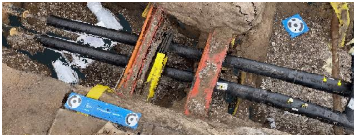
Figur 2: De blå skalapinde og tiepoints placeret ved ledningsgrav. Kilde: LE34.
