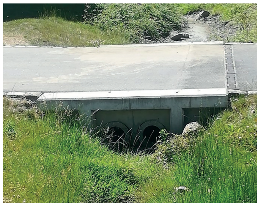
Figur 1. Bro over mindre vandløb i Vennelystparken i Aarhus, hvor en hydrologisk tilpasning vil være nødvendig for at beskrive vandets strømning i grøften. Bemærk, at vandets strømning under vejen ikke kan detekteres ved den luftbårne opmåling af højdemodellen.
