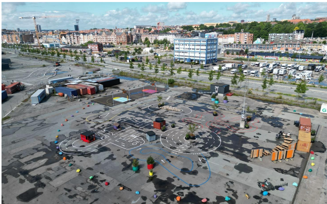
Teknik og Miljø, Aarhus Kommune: Billede taget i sydvestlig retning, mod bymidten.
