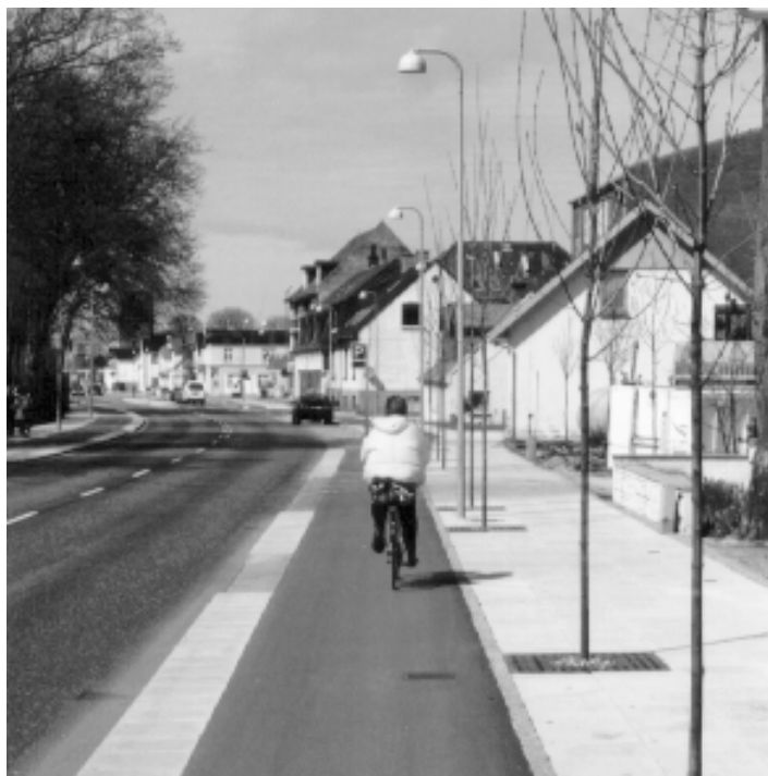
Cykelsti etableret i forbindelse med projektet (Thistedvej i Nørresundby)
