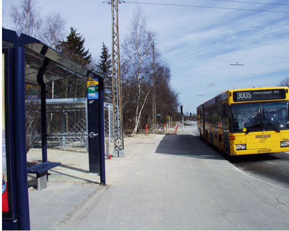
Nordre Ringvej/Mellemtoftevej, sydgående retning Under opførelse, marts 2003
