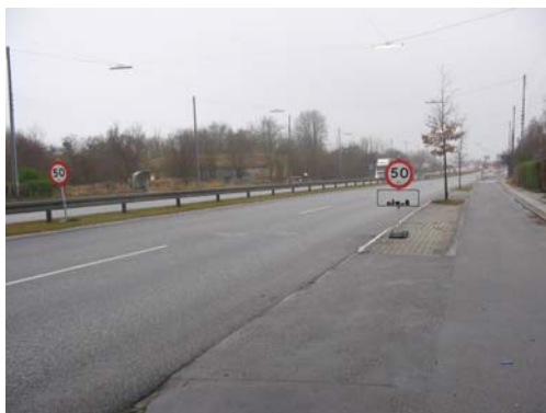
Figur 2 Før-situation om dagen med 50 km/t-hastighedsbegrænsning vha. konventionelle, stationære tavler.
