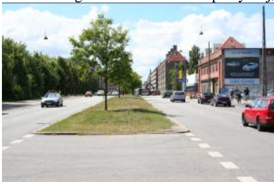
Foto 2. Eksempel på fordelingsgade (Jagtvej)
