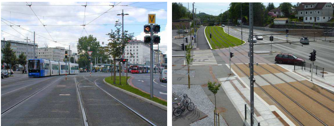
Figur 4: Midtliggende tracé i Bremen(tv) og sideliggende tracé i Bergen(th). Bemærk forskellige belægnings og særskilte svingbaner.
