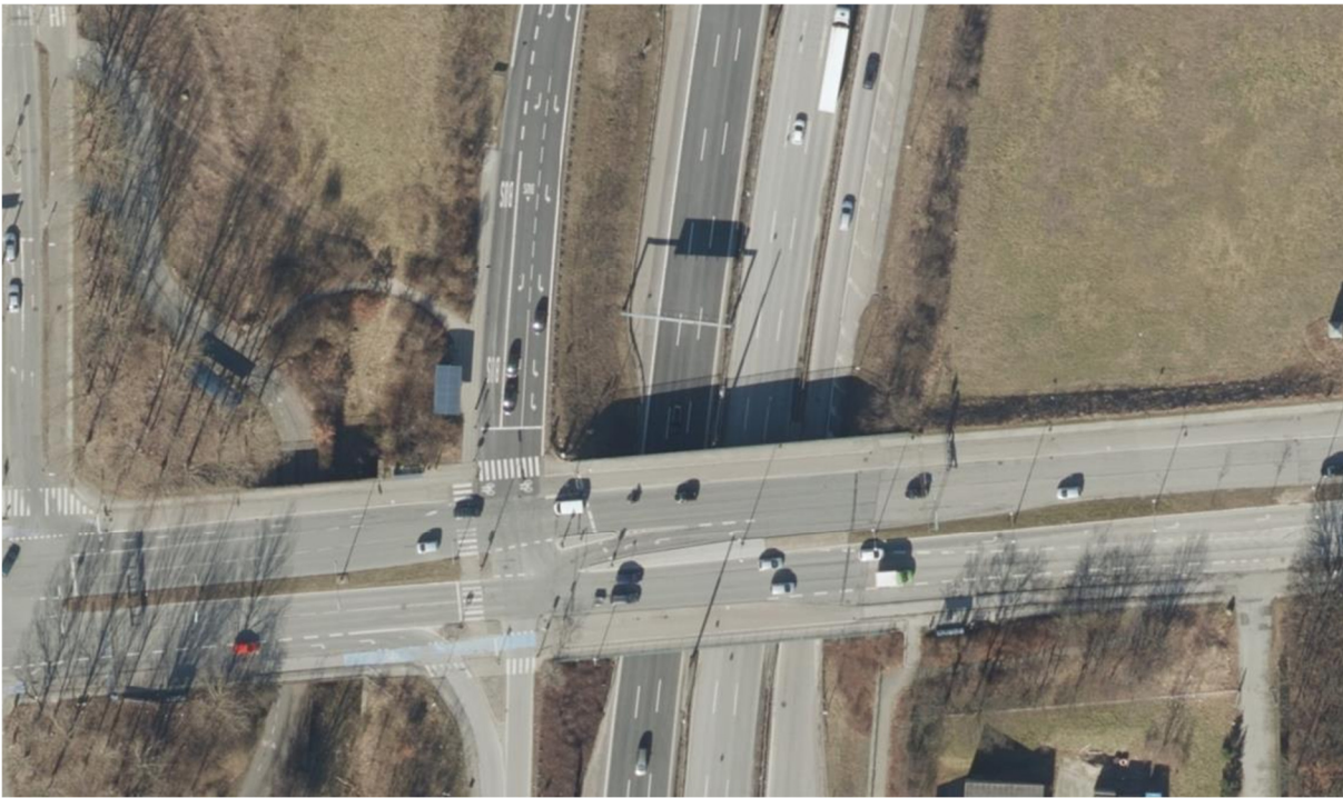
Figur 5 Sydgående frakørselsrampe på Helsingørmotorvejen ved Klampenborgvej
