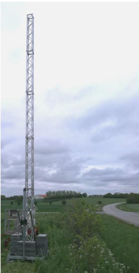
Figur 3: Mobil mast opsat i krydset ved Manstrup.
