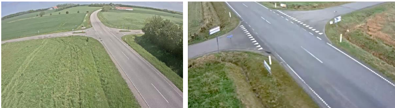
Figur 4: Kameraview fra de undersøgte kryds ved Manstrup (venstre) og Aabybro (højre).
