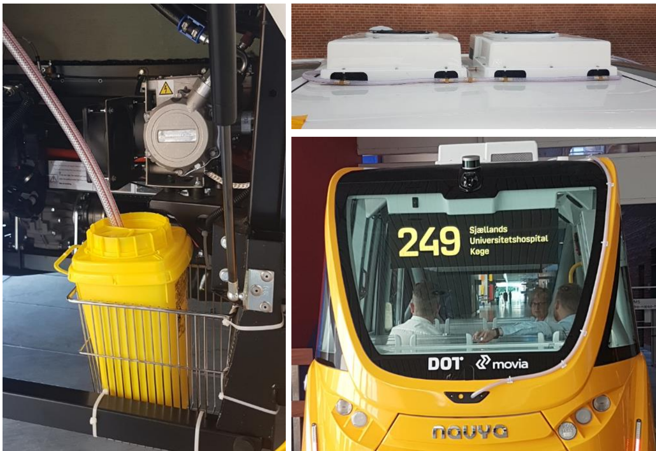
Figur 7: Løsning af problem med kondensvand på gulvet i vandrehallen fra bussens aircondition-anlæg. Fotos: Mads Bergendorff.
