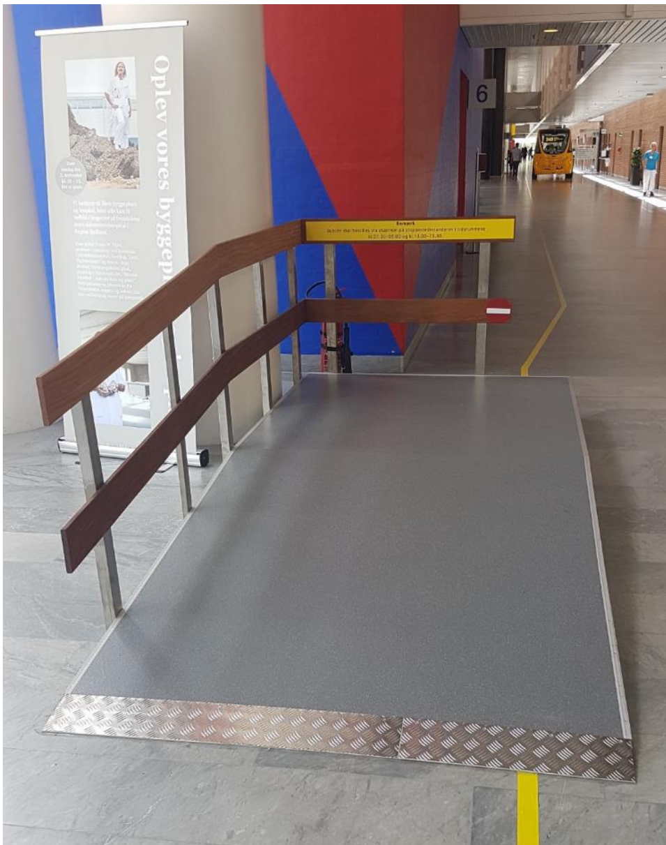
Figur 6: Eksempel på rampe til førerløs bus på Sjællands Universitetshospital, Køge (stoppested "Køge Høns"). Foto: Mads Bergendorff.
