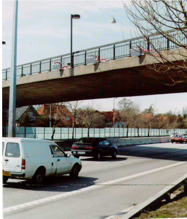
Fig 3.: Målepunkt for RIS med interrogatorer placeret på en bro
