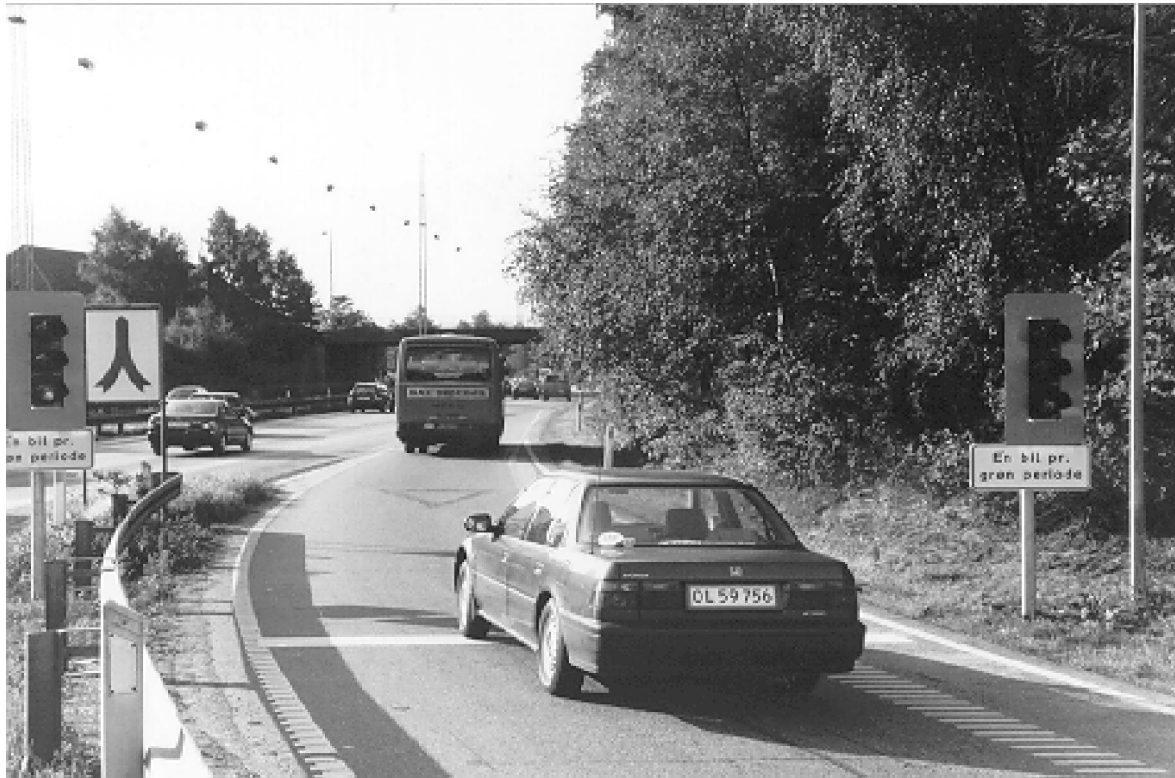
Figur 4. Tilfarten fra Nærum med rampedoseringsanlægget i drift.
