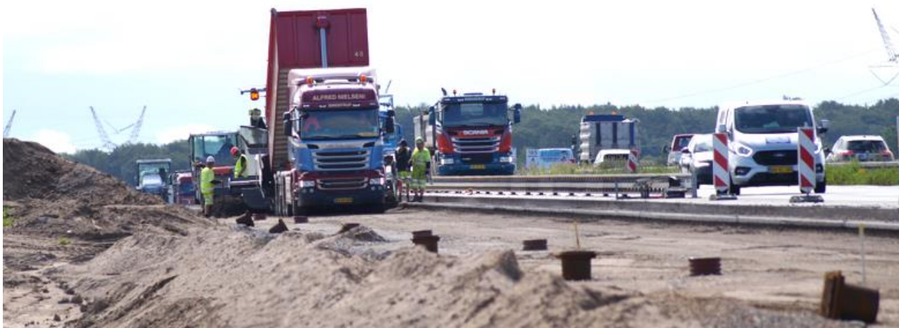
Fig. 3: Udlægning af BSM bærelag ved udvidelsen af Den Fynske Motorvej, M40
