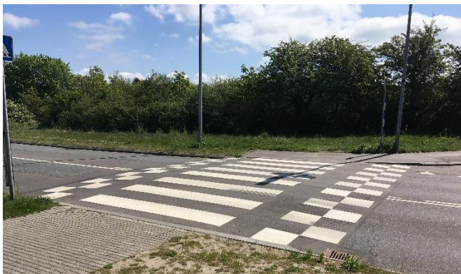
Hævet fodgængerovergang ved Ladegårdsparken i Holbæk Kommune. Foto COWI.
